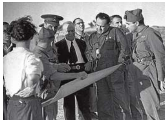
El general ASENSIO (segundo por la derecha) y Largo Caballero supervisan las tareas previas de la voladura del Alcázar de Toledo.
