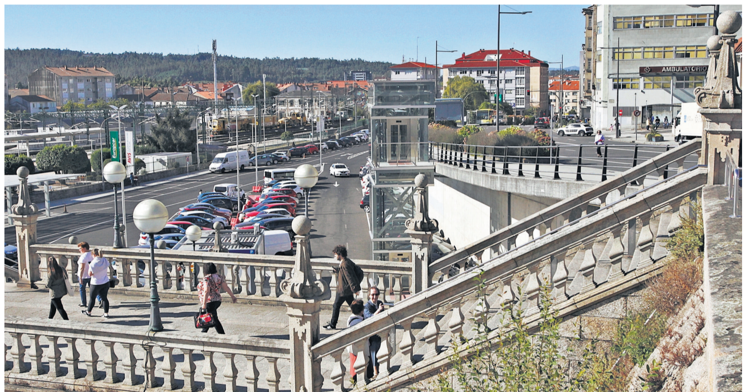
ADAPTACIÓN AL PROYECTO INTERMODAL. Imagen actual de los accesos desde la rúa do Hórreo a la estación de tren. Foto: Antonio Hernández
