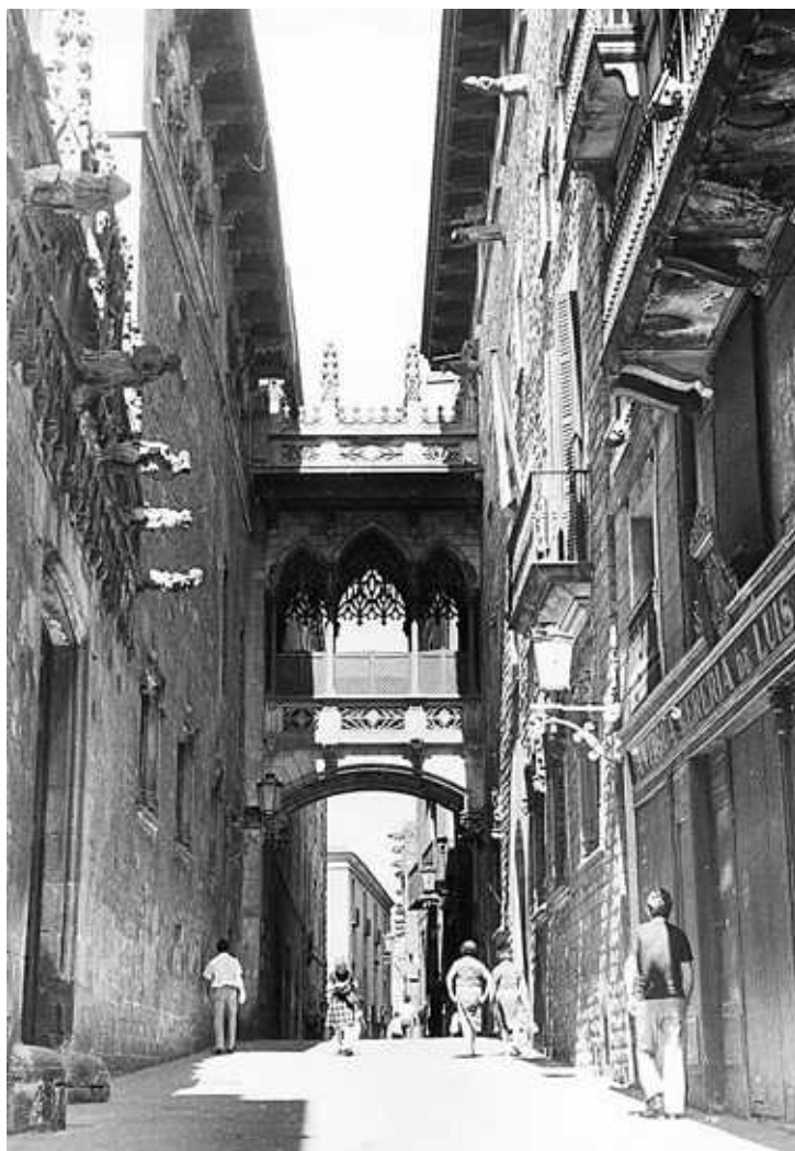
Este puente fue objeto de críticas severas
