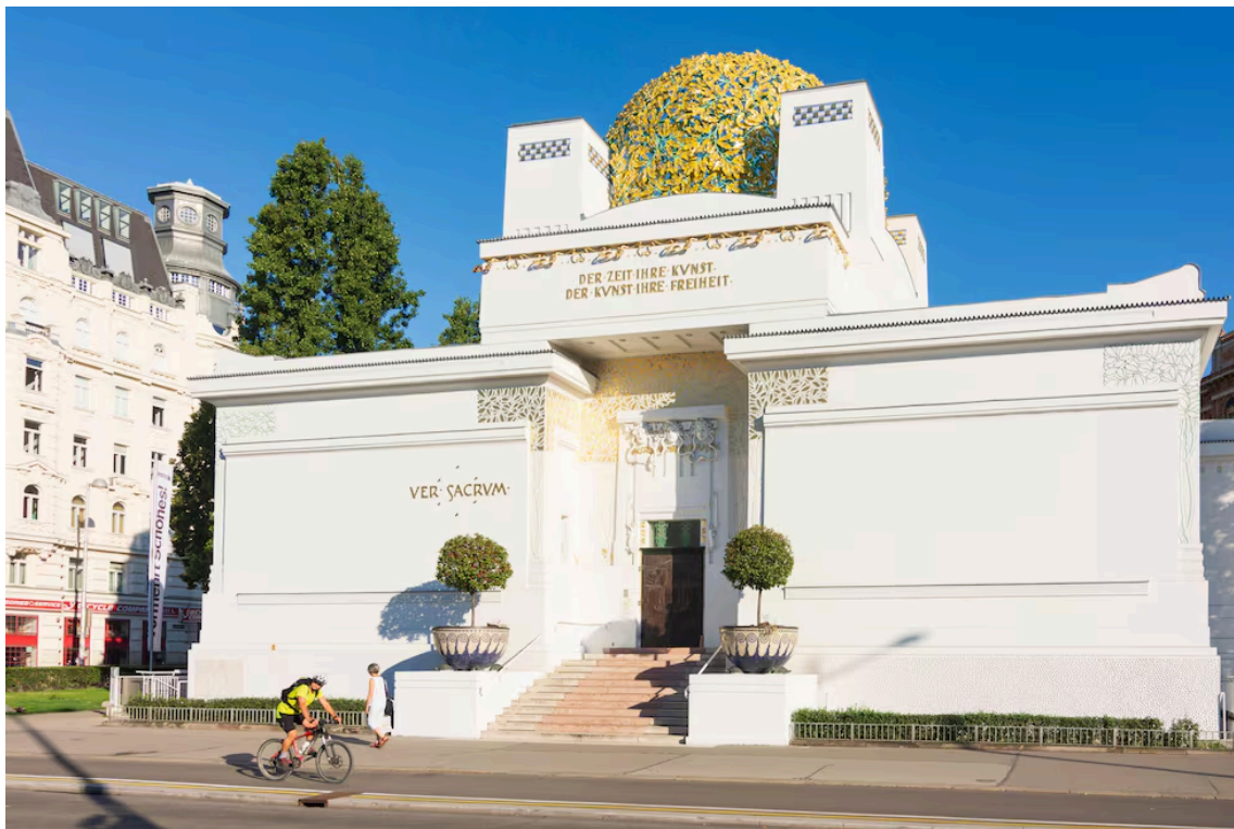
L'edifici de la Secessió, símbol de la modernitat del fi de segle vienès. ALAMY STOCK PHOTO
